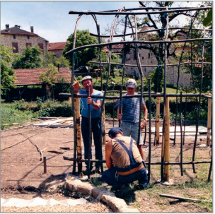
Démarrage de la tonnelle en gaulettes de châtaigner. Rosiers et chèvrefeuilles devenus trop lourds, on devra la renforcer (Robert Berti, André Teyssières et Frip...)
